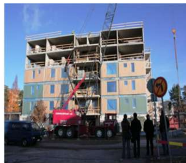
а – в Австрии; б – в Финляндии Монтаж гибридных стеновых панелей в строящемся здании
