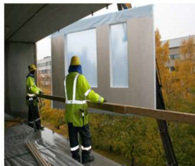
а – в Австрии; б – в Финляндии Монтаж гибридных стеновых панелей в строящемся здании
